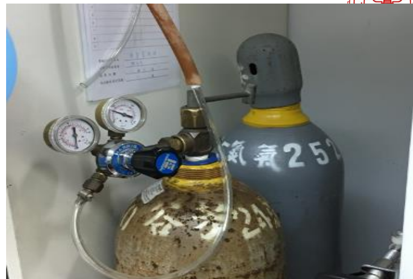
烤箱使用氮氣，請考量相關缺氧風險、人員操作鋼瓶風險
